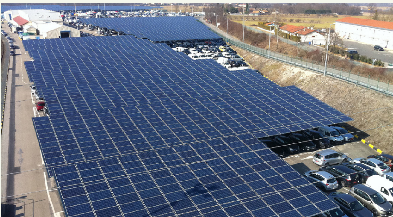
Biloppstillingsplass utenfor Lyon i Frankrike, dekket av solcellepaneler. (Foto: Scatec)
