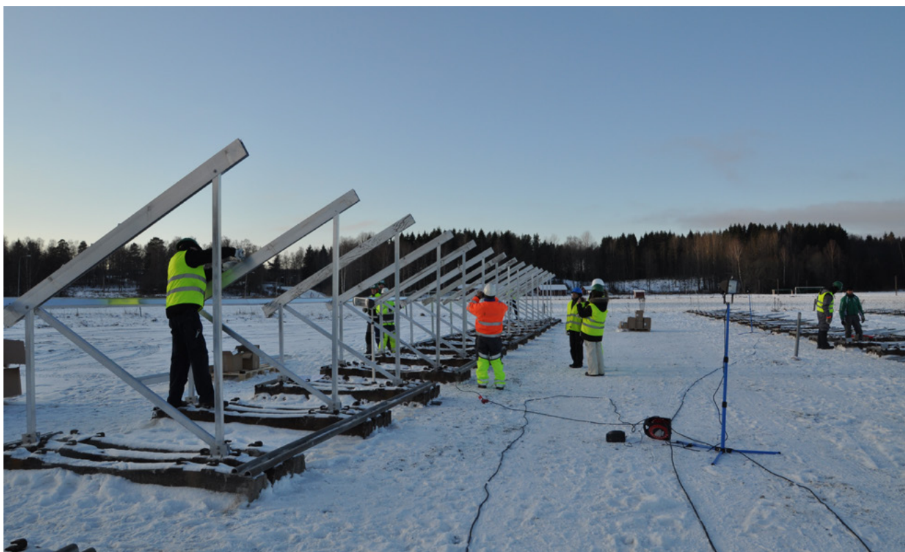
Eksempel på ballastfundament, her gjenbrukes gamle jernbanesviller som ballast ved Glava Energy Center i Sverige. (Foto: Multiconsult)
