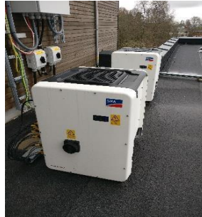
Eksempel på vekselretter til industribygg
