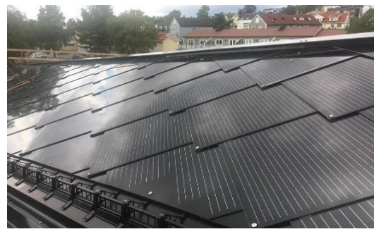
Nærbilde av solcelletakstein (BIPV)
