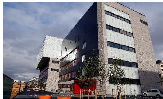
Det sorte på fasaden på Brynseng skole er solceller (BIPV)
