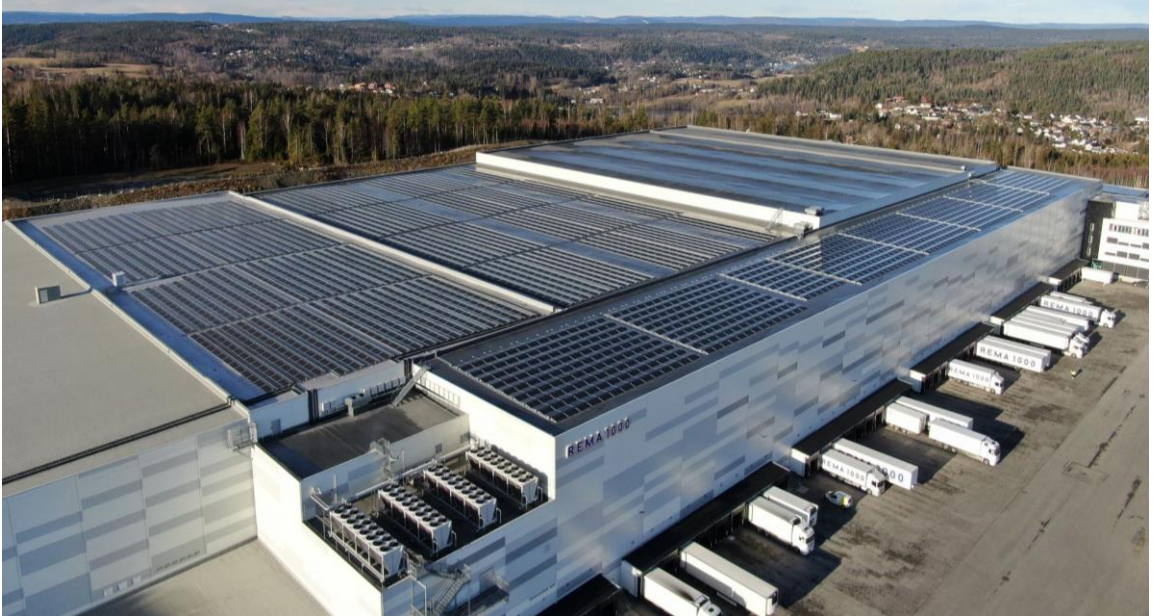
Figur 24: REMA Distribusjon Stavanger. Foto: Synnøve Gautesen Figur 25: REMA Distribusjon Østlandet. Foto: Solcellespesialisten
