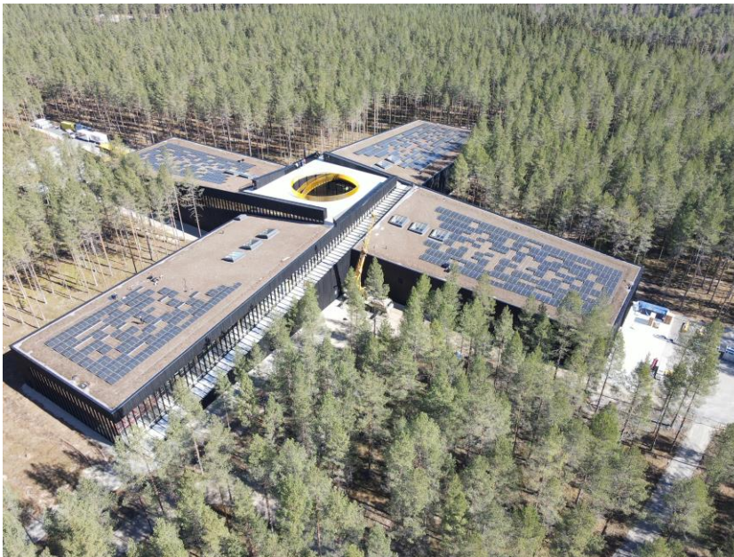
Figur 37: Foto: Solcellespesialisten, fra møbelfabrikken 'The Plus' på Magnor
