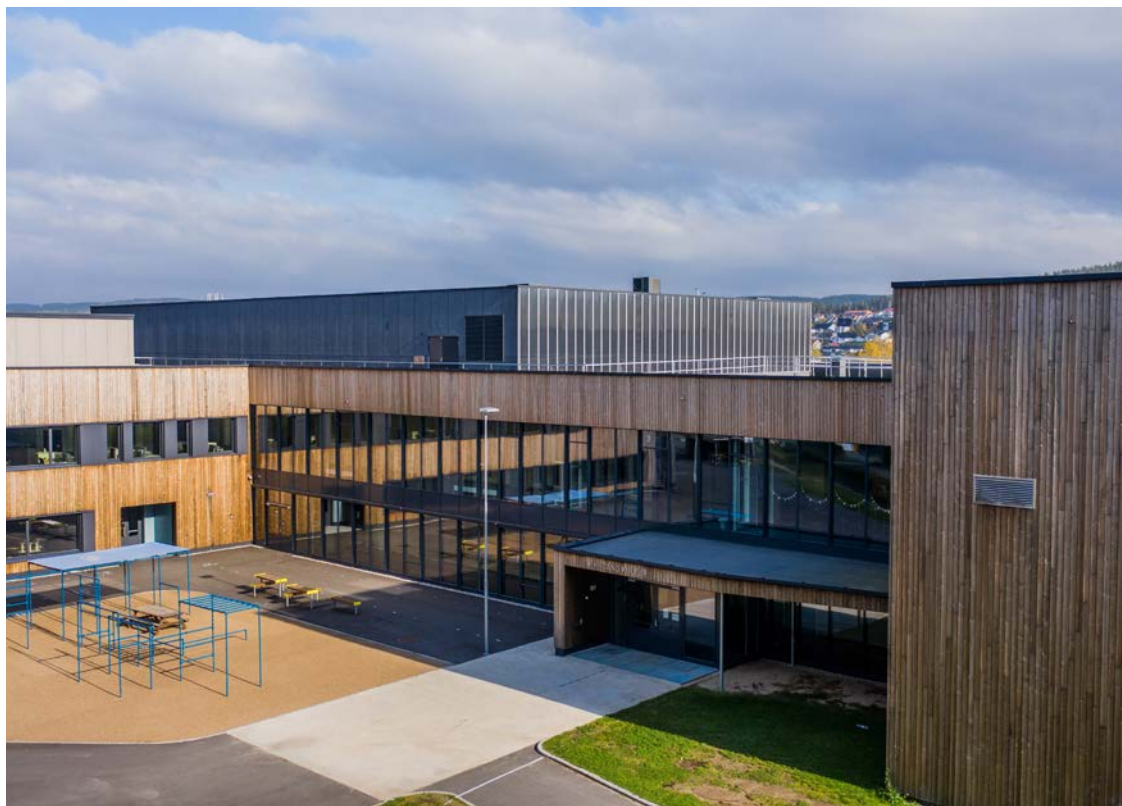
Solvarmeanlegg kan bidra til både miljøvennlige og vakre bygg. Foto: Inaventa Solar
