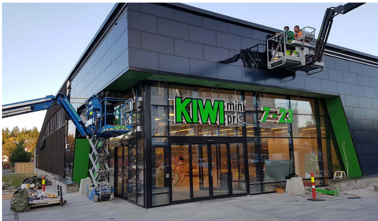
Bygningsintegreerte solcellepaneler (BIPV) tillater solkraftproduksjon fra både tak og fasader. Foto: FUSen
