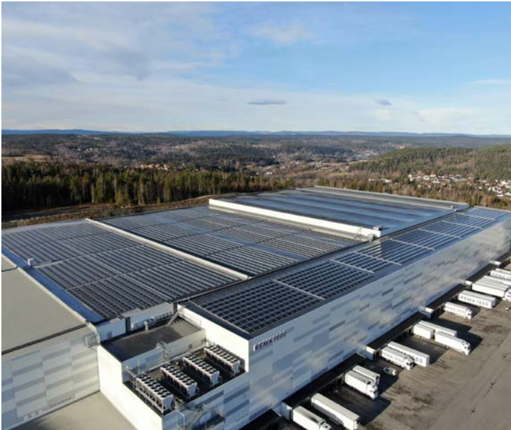
Solcelleanlegg på industritak kan stå for stor, lokal produksjon av fornybar kraft. Foto: Solcellespesialisten
